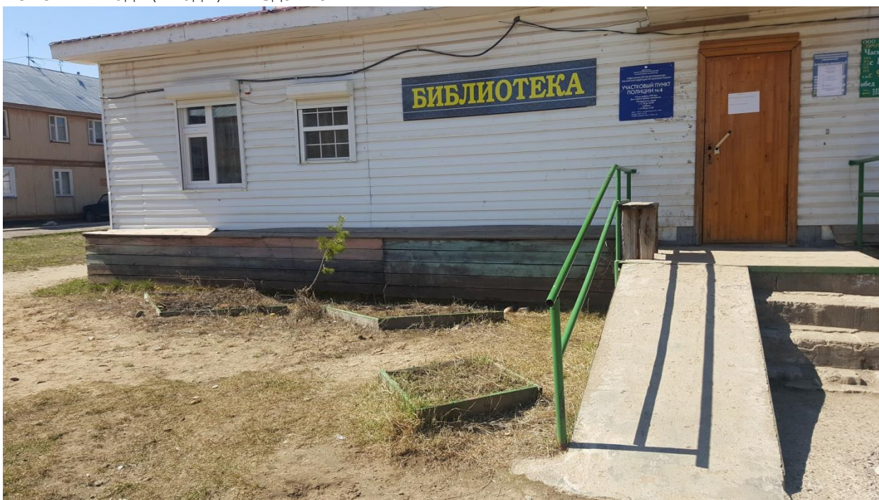
Фото 2 Вход (входы) в здание
