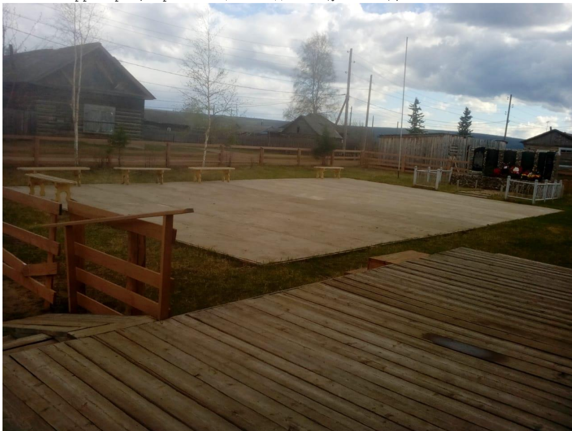
фото 1 Территория, прилегающая к зданию (участок),
