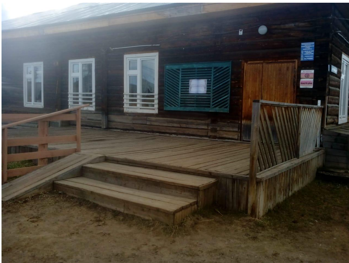
фото 2 Вход (входы) в здание
